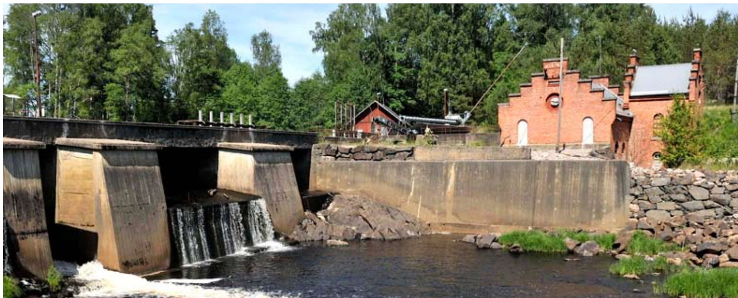
Karlsfors kraftstation, Foto: Leif Gustavsson
